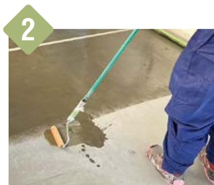
2 刷毛・ローラーで施工し、規定量を溜り・塗りむら・塗り残しが無いように均一に塗布する。
