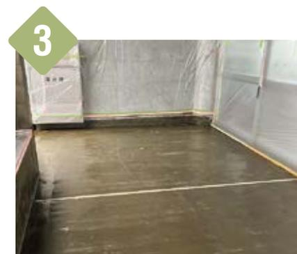
3 1回目塗布乾燥後に状態を確認し、躯体に含侵しなくなるまで塗り重ねる。
